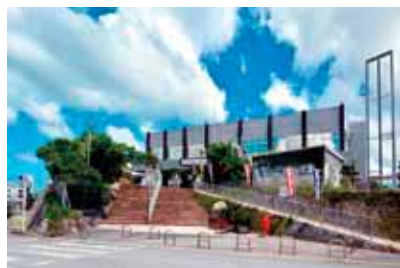
解体前の旧庁舎 2018年(平成30)年4月
